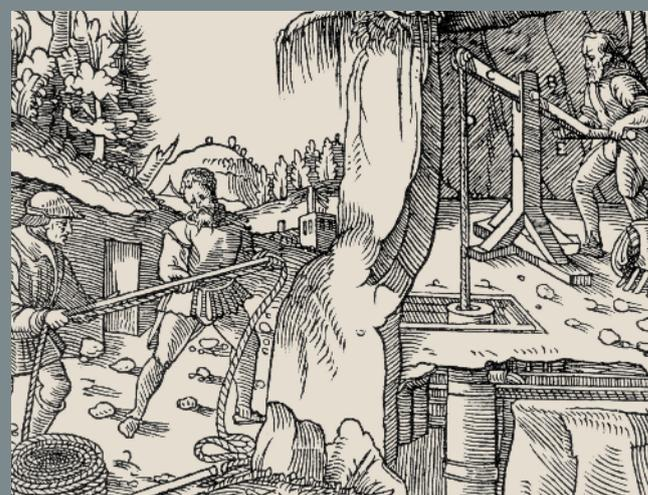
Pompe à roue hydraulique. Agricola. *De re metallica*, 1556.
